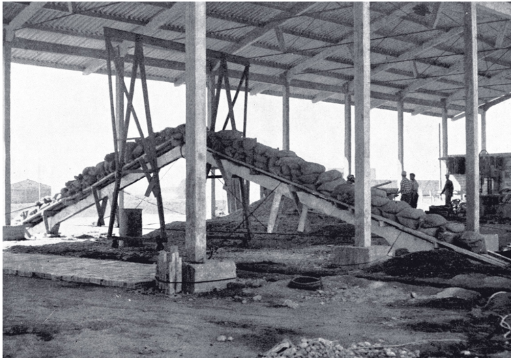
Detalle de la nave en construcción
