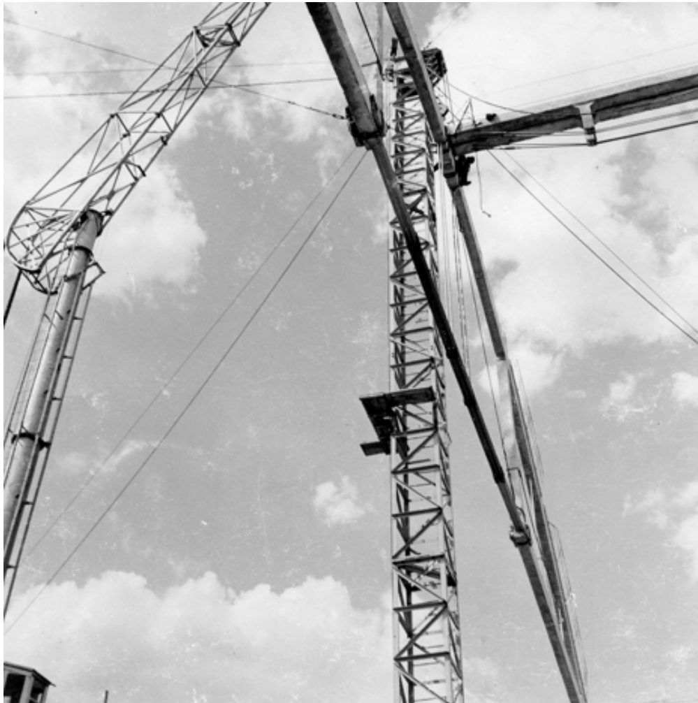
Detalle de la nave en construcción
