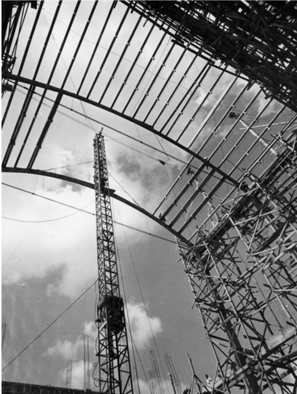
Detalle de la nave en construcción
