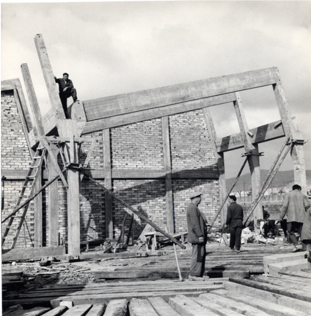
Detalle labores de construcción
