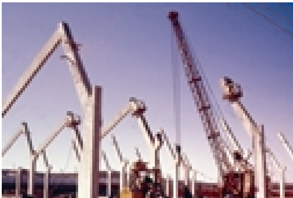
Vista de la nave en construcción
