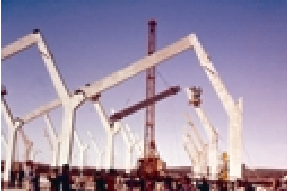
Vista de la nave en construcción
