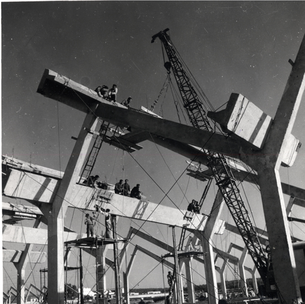
Detalle de la nave en construcción
