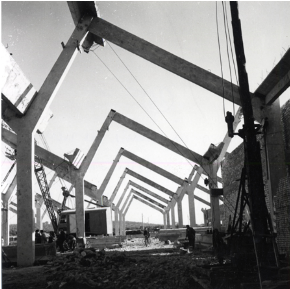
Detalle de la nave en construcción
