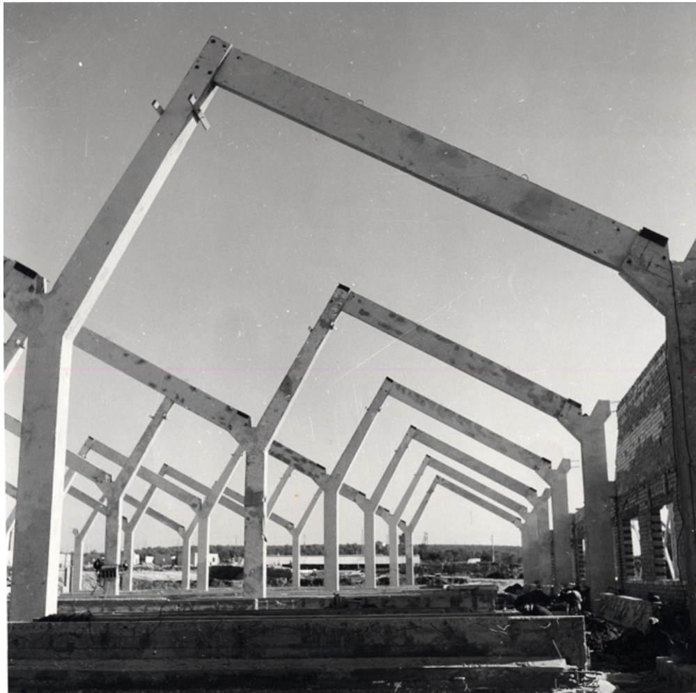
Vista de la nave en construcción
