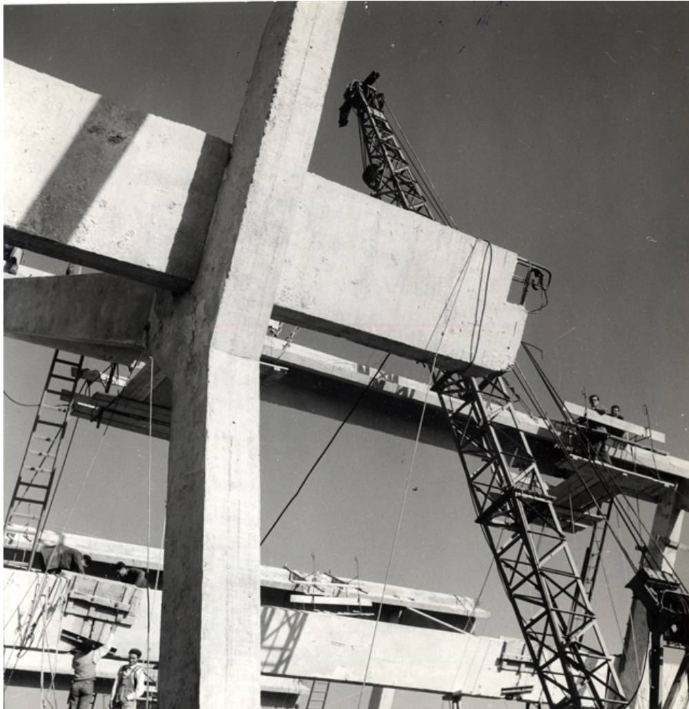
Detalle de la nave en construcción
