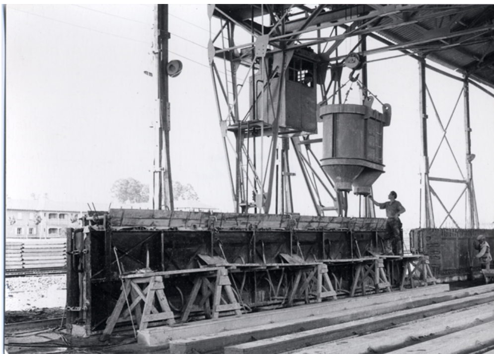
Detalle del hormigonado
