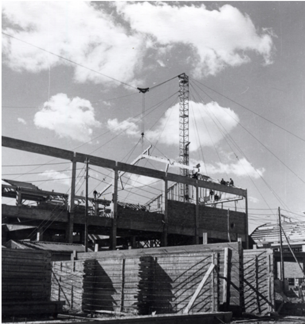
Vista de las naves en construcción
