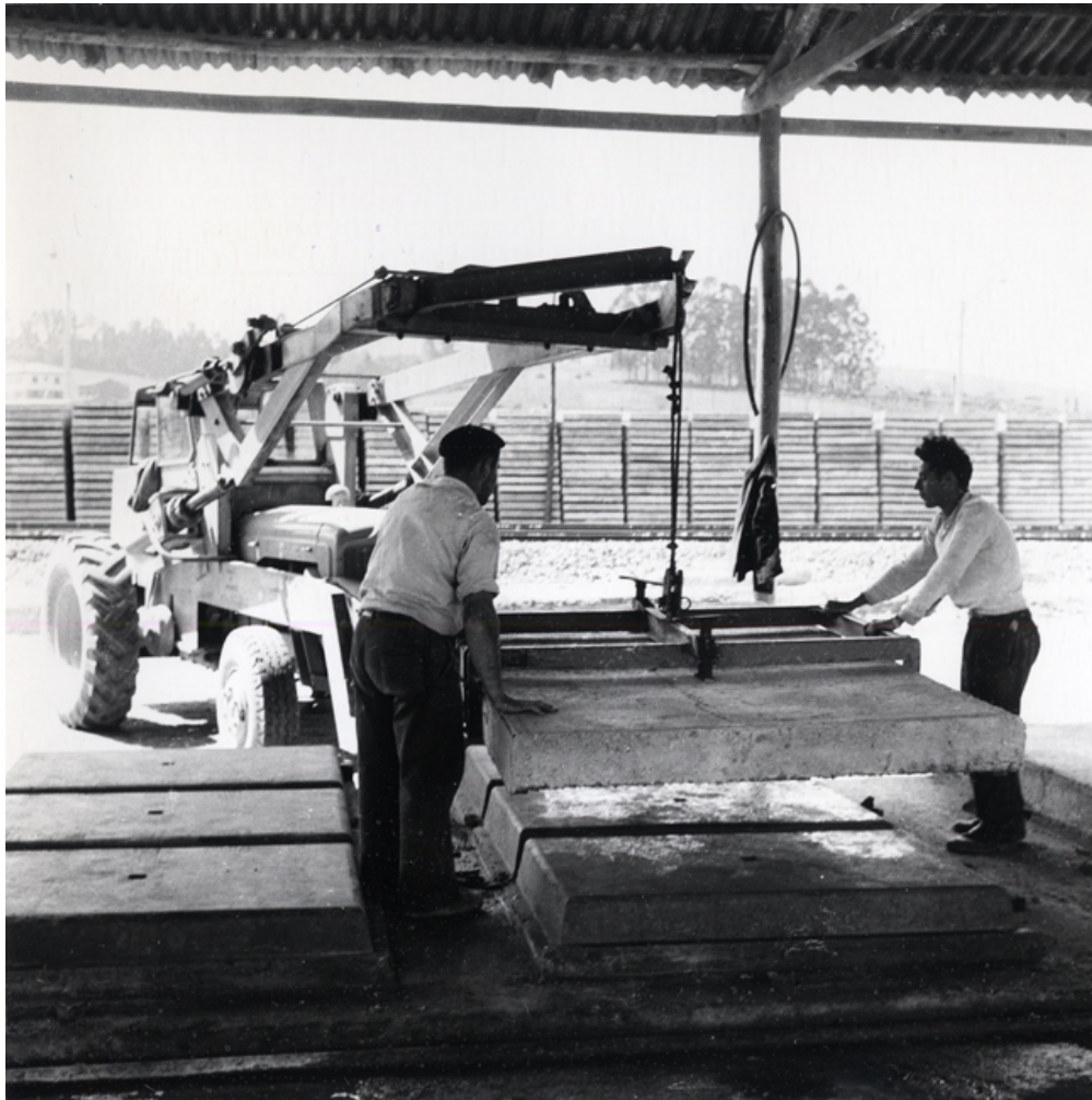
Vista operarios trabajando
