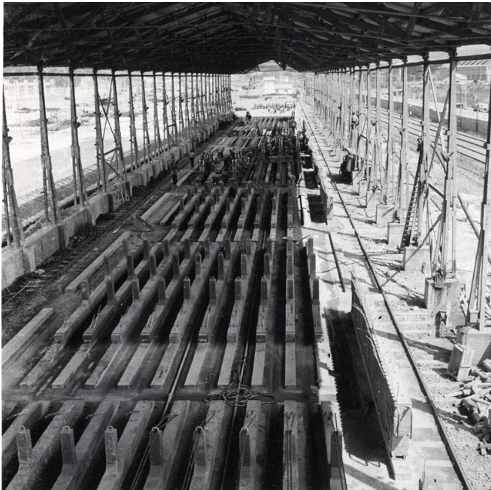
Vista interior taller prefabricación de vigas
