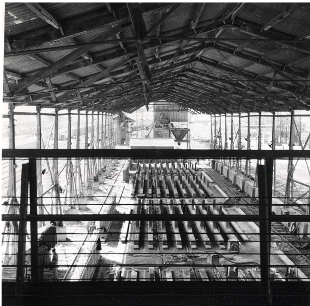
Vista del interior de las naves
