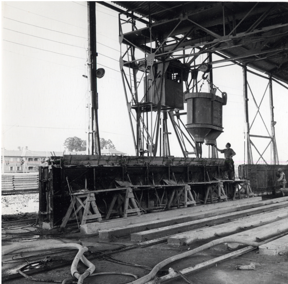
Detalle del interior de las naves en construcción
