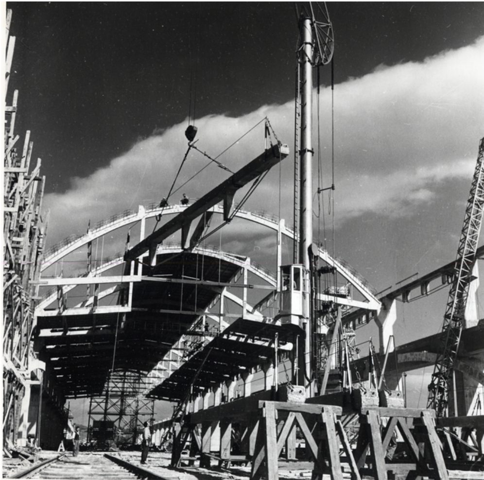
Vista de las naves en construcción
