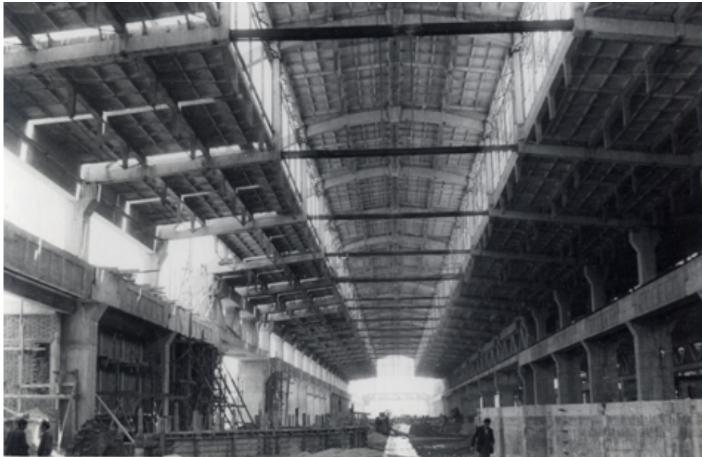
Vista del interior de las naves
