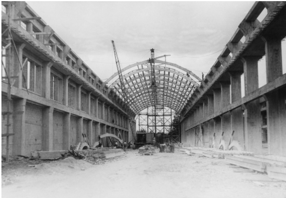
Vista del interior de la factoría en construcción
