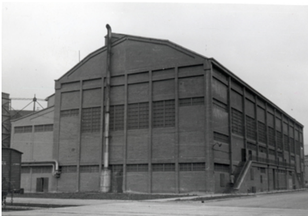
Detalle de las instalaciones
