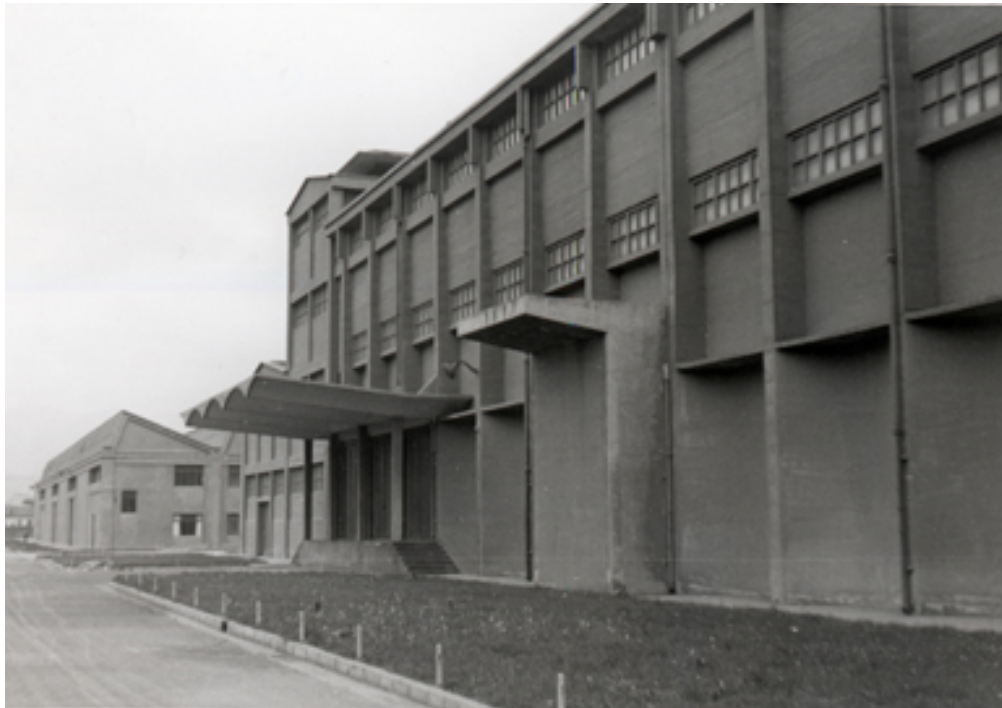
Detalle de las instalaciones
