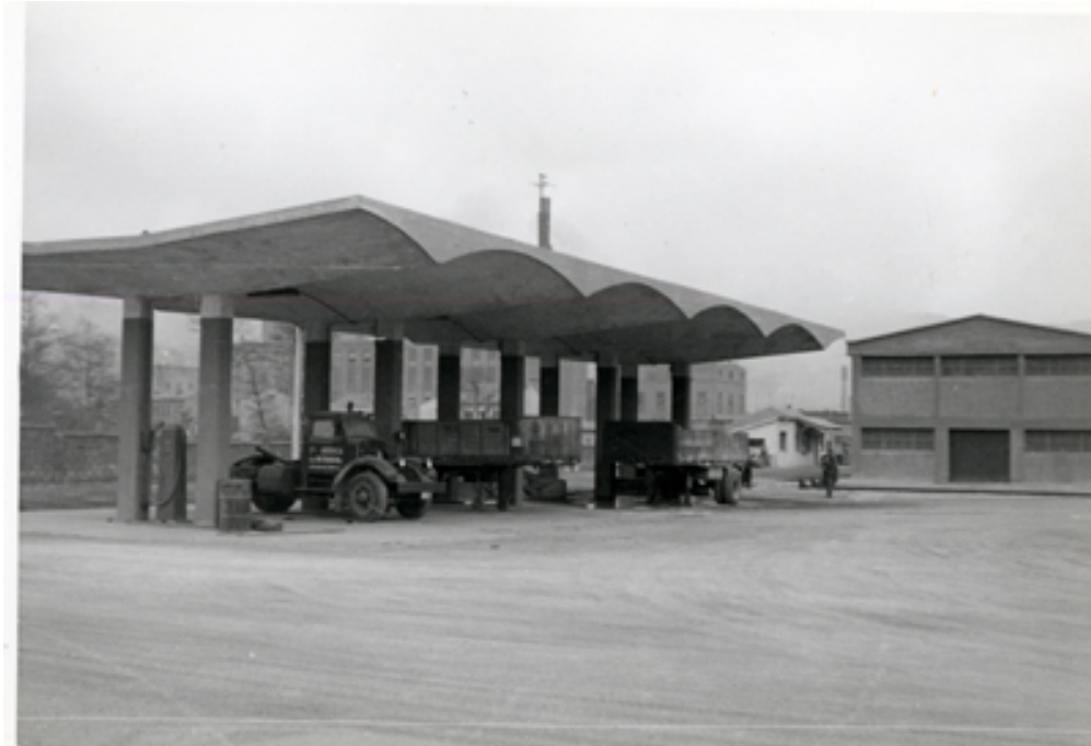
Detalle de las instalaciones
