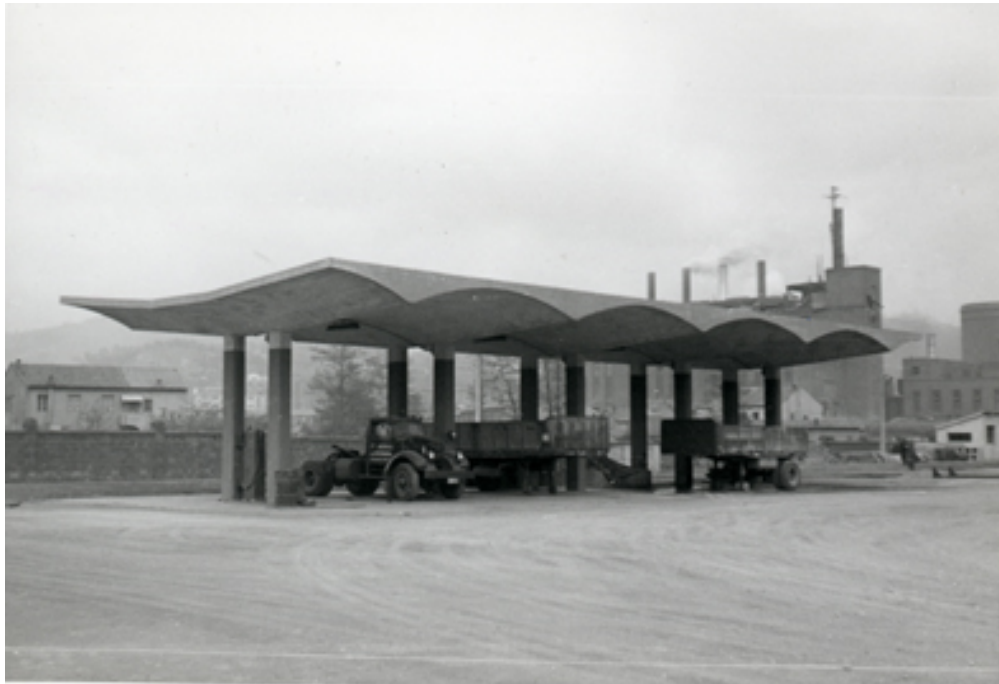
Detalle de las instalaciones
