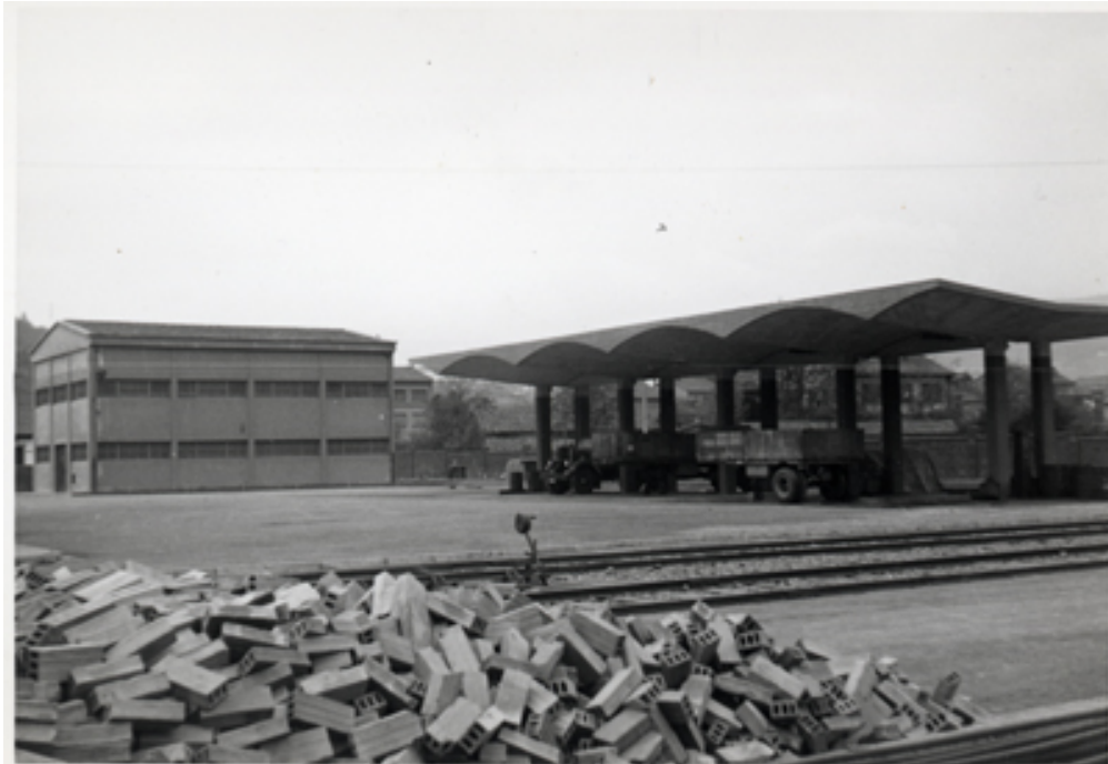
Detalle de las instalaciones
