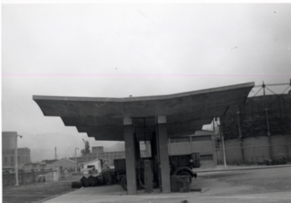
Detalle de las instalaciones
