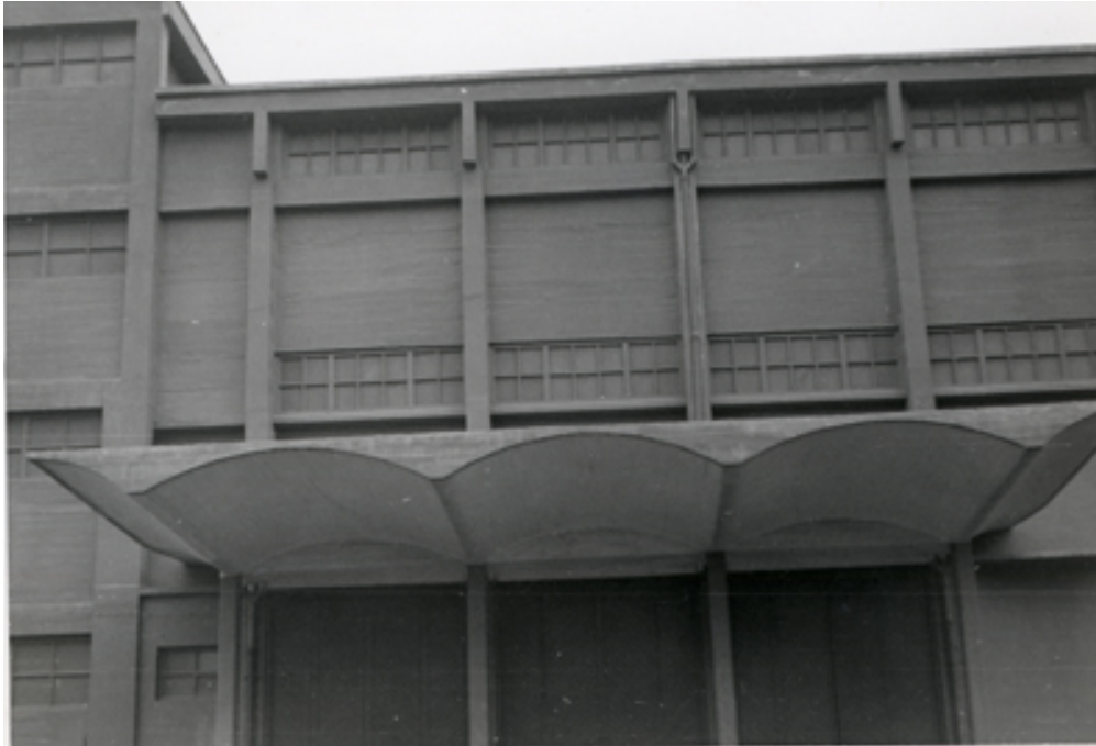
Detalle de las instalaciones
