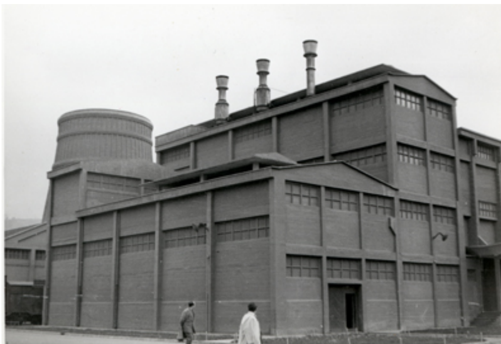
Detalle de las instalaciones
