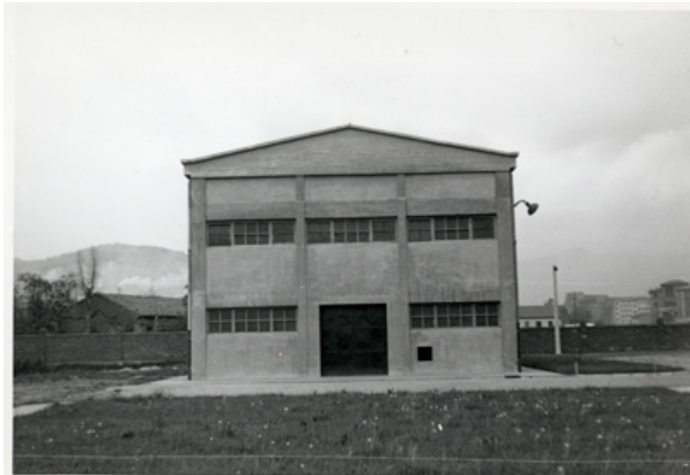
Detalle de las instalaciones
