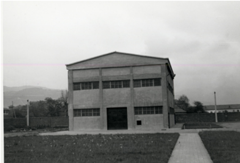
Detalle de las instalaciones
