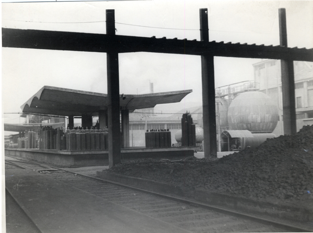
Detalle de las instalaciones
