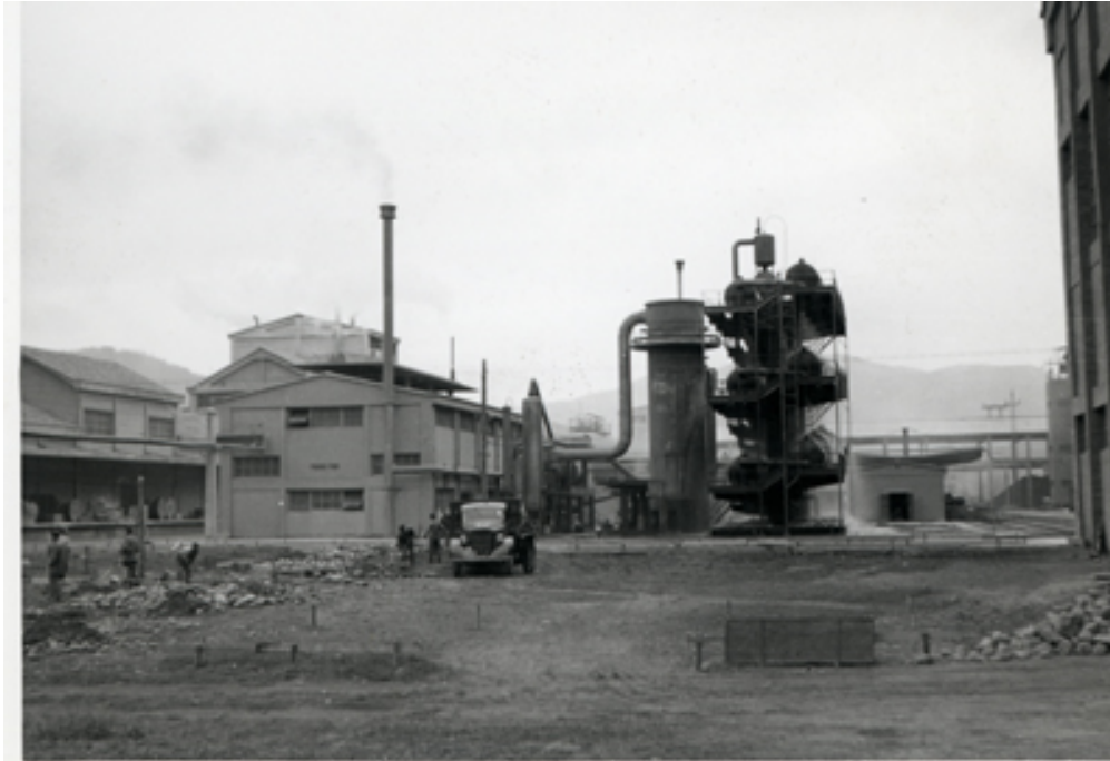
Detalle de las instalaciones
