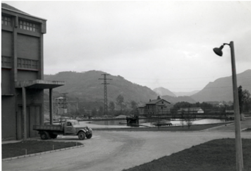
Detalle de las instalaciones
