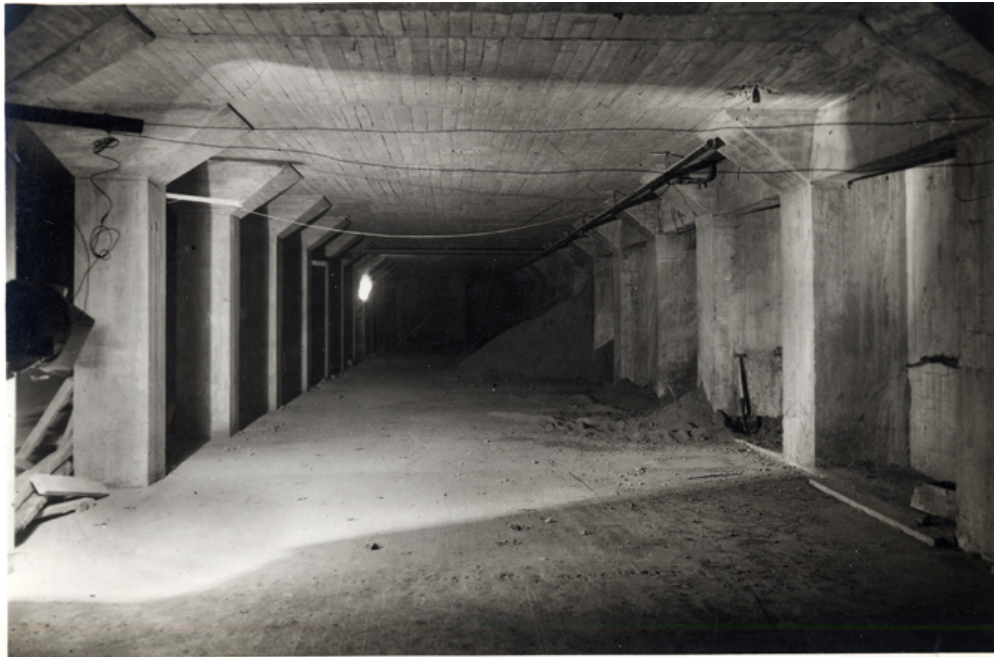
Detalle del interior de la factoria en construcción
