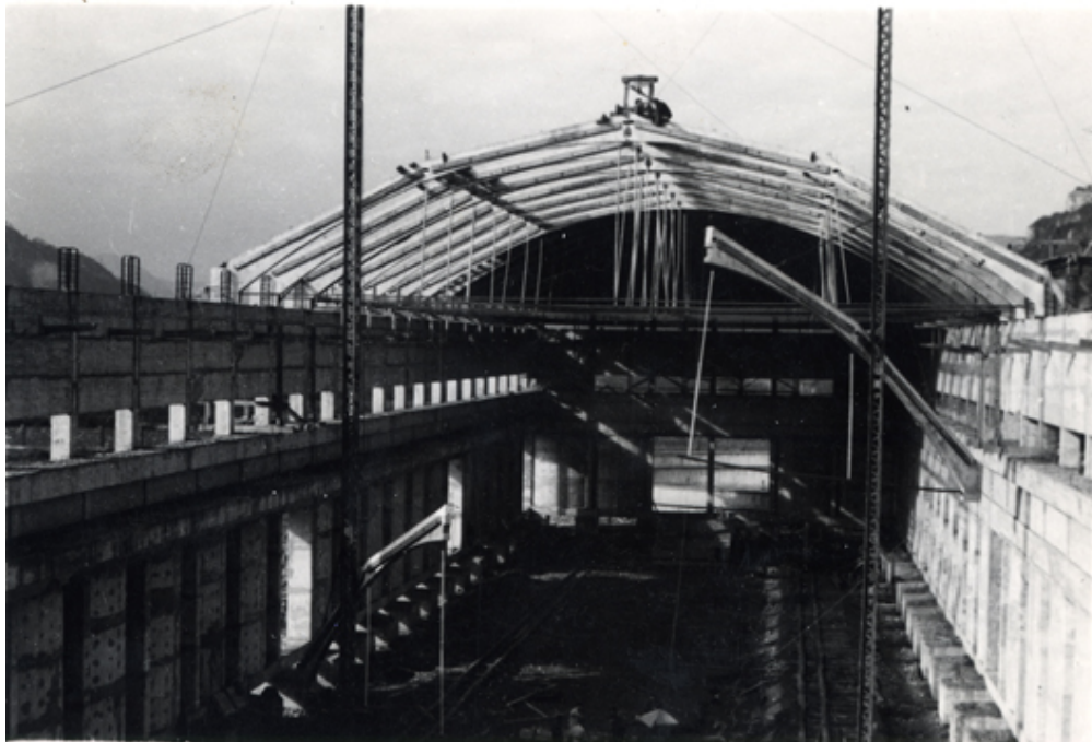
Vista del interior de la factoría en construcción
