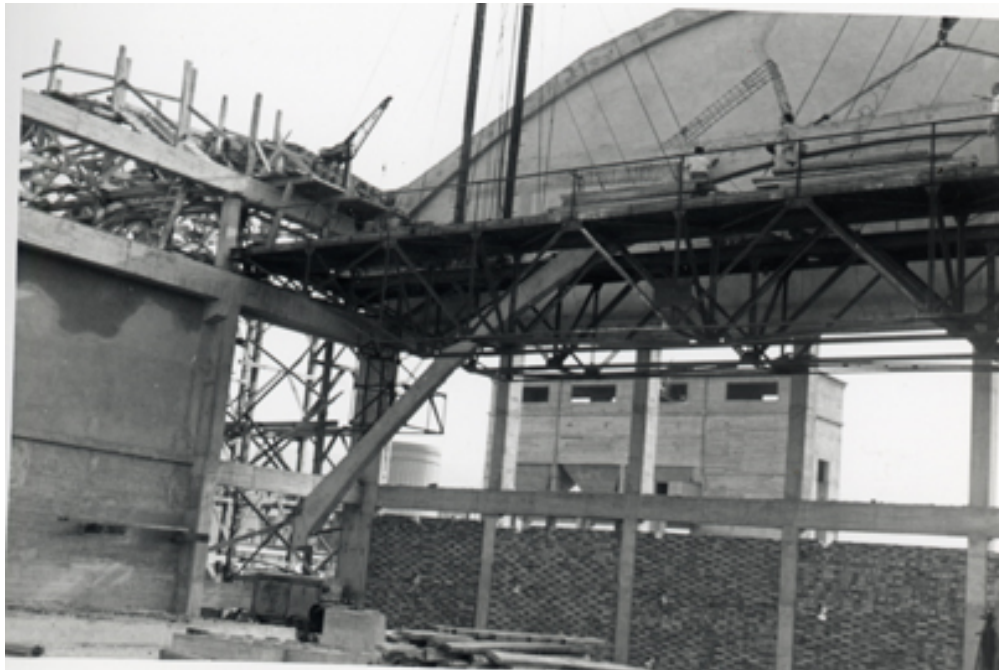
Detalle de construcción
