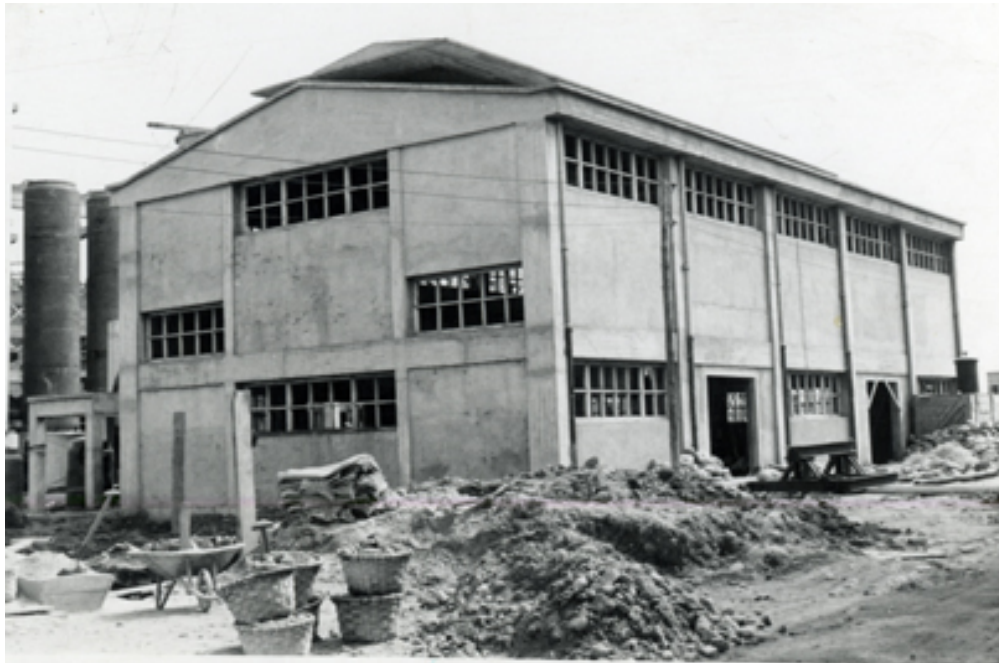
Detalle de las instalaciones
