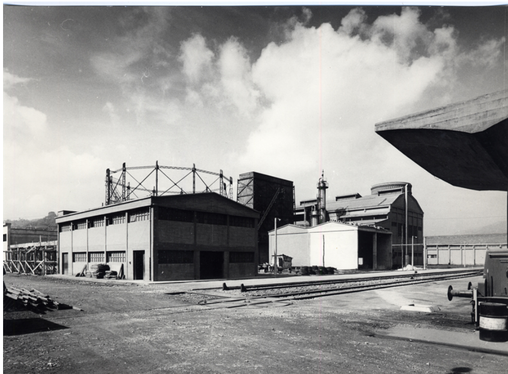
Detalle de las instalaciones
