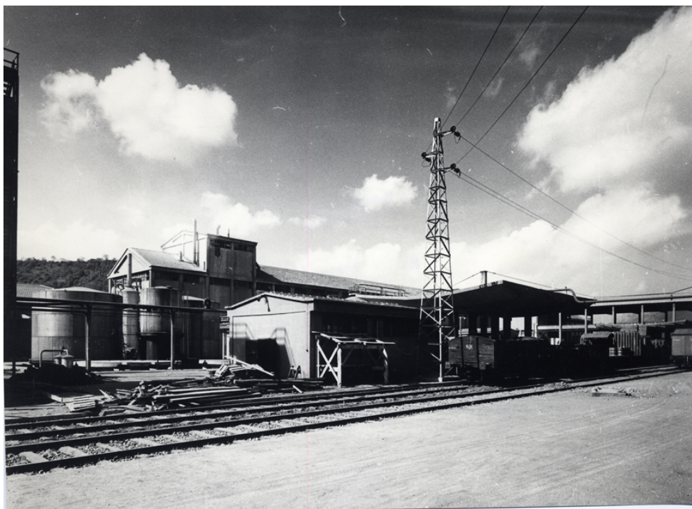
Detalle de las instalaciones
