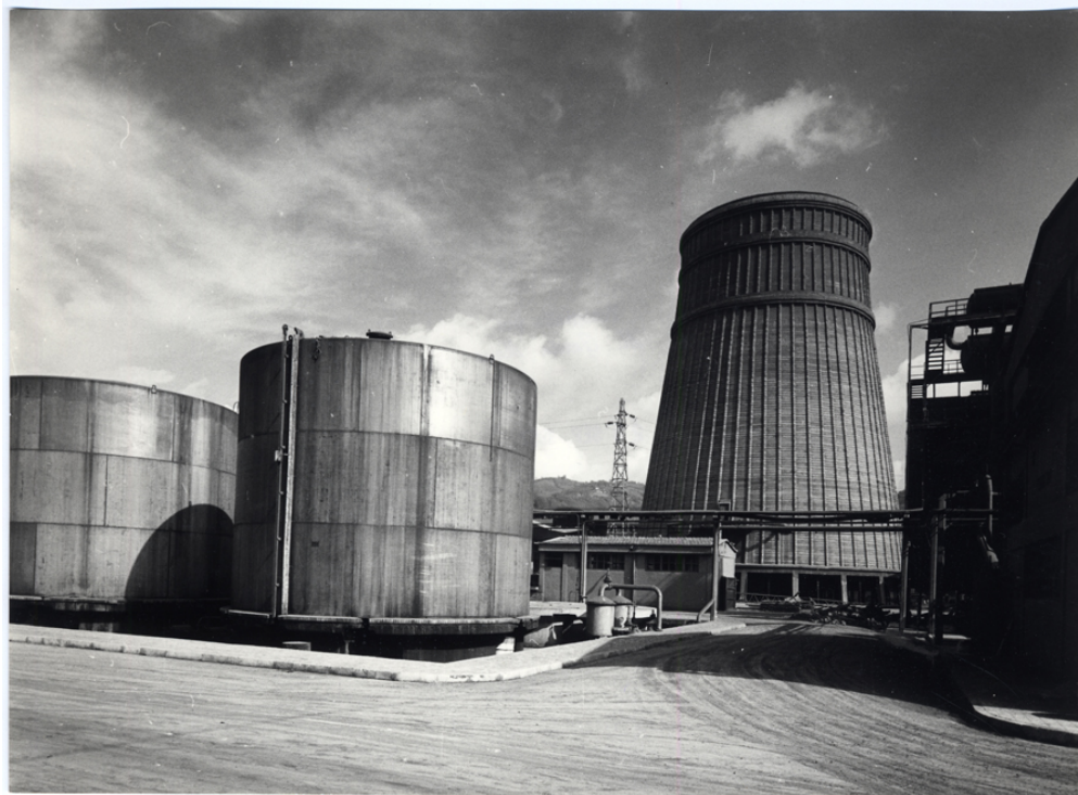
Detalle de las instalaciones
