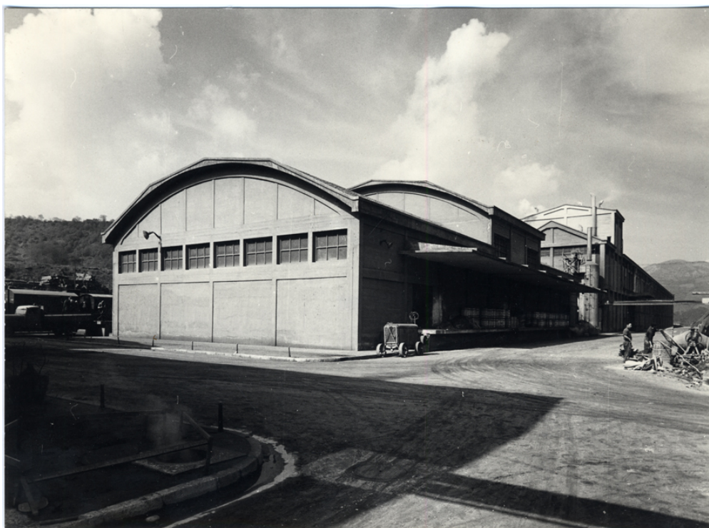
Detalle de las instalaciones
