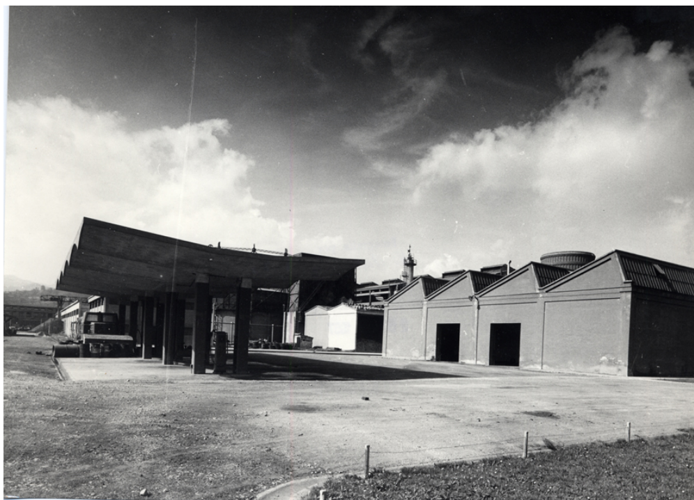
Detalle de las instalaciones
