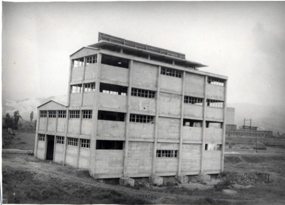
Detalle de las instalaciones
