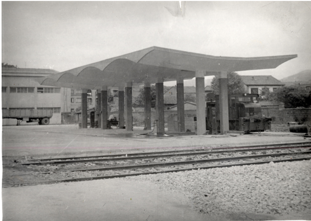
Detalle de las instalaciones
