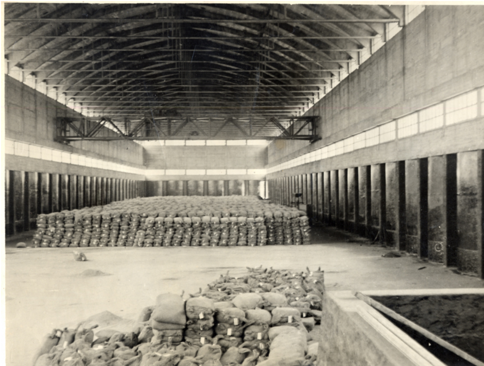
Vista del interior de la factoría en construcción
