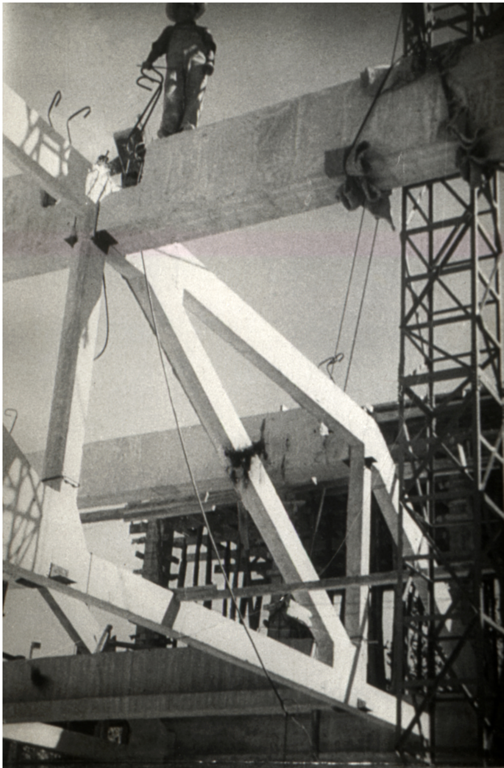
Detalle de construcción
