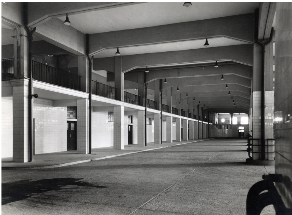
Vista del interior de la estación
