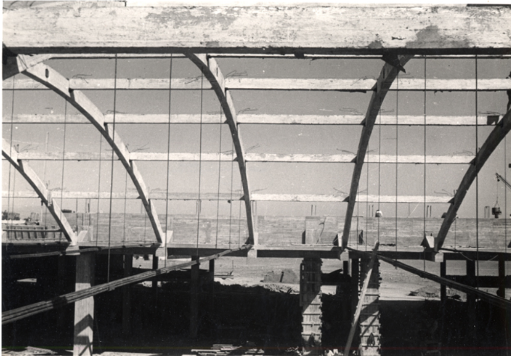
Detalle de construcción
