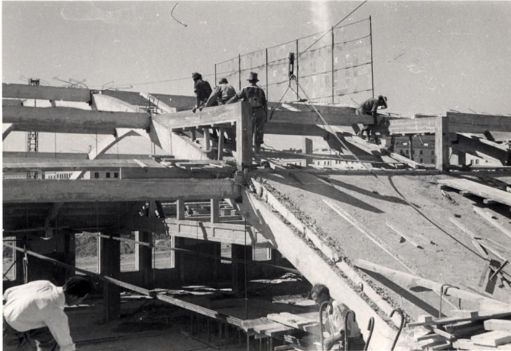
Detalle de la construcción de la cubierta
