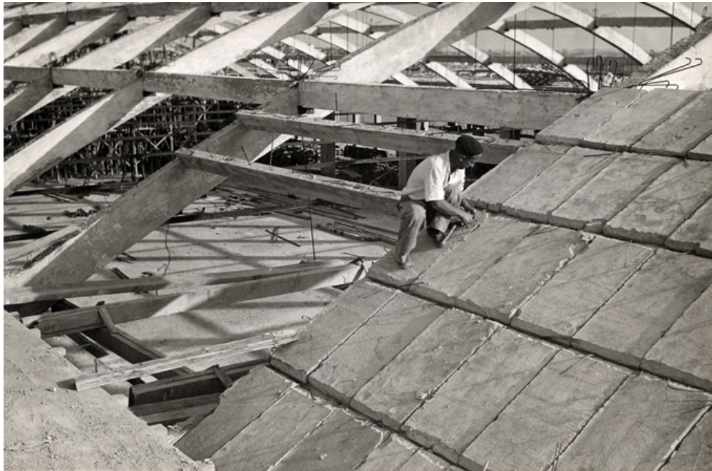
Detalle de la construcción de la cubierta
