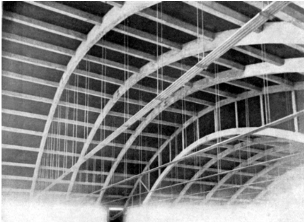
Detalle de construcción
